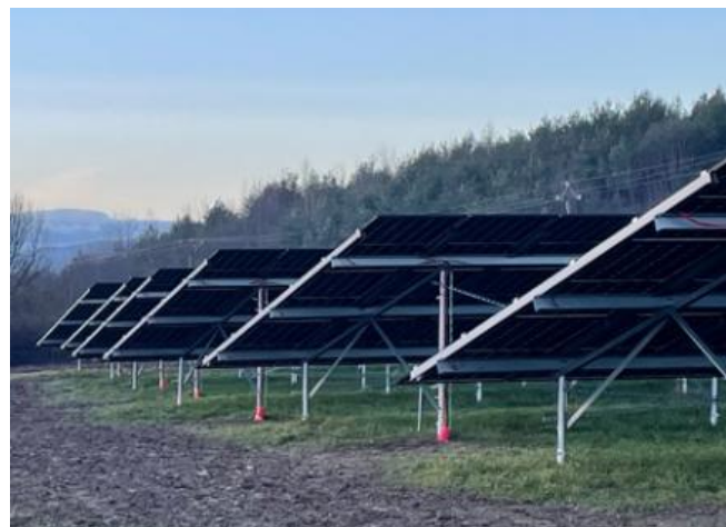
Exemple de structures fixes. Source : parc solaire d'Enercoop AURA à Beauregard-Vendon dans le Puy-de-Dôme (63) sur un délaissé d'autoroute
