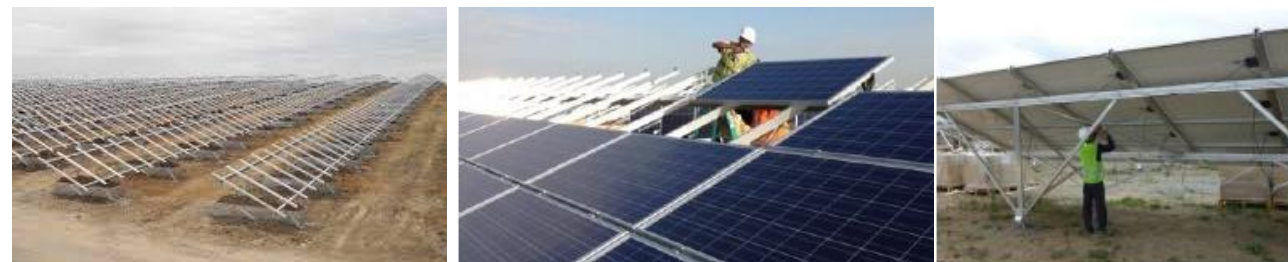
Photographies d'illustration de la phase de travaux
