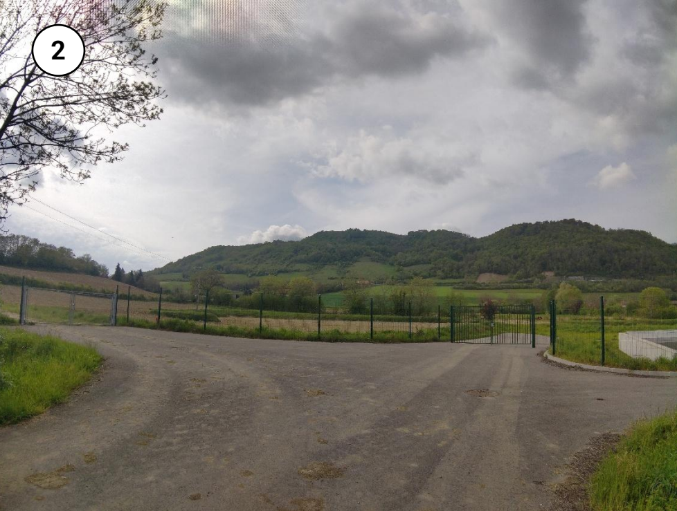
Accès au complexe de la station d'épuration depuis ch. de la Rongy
