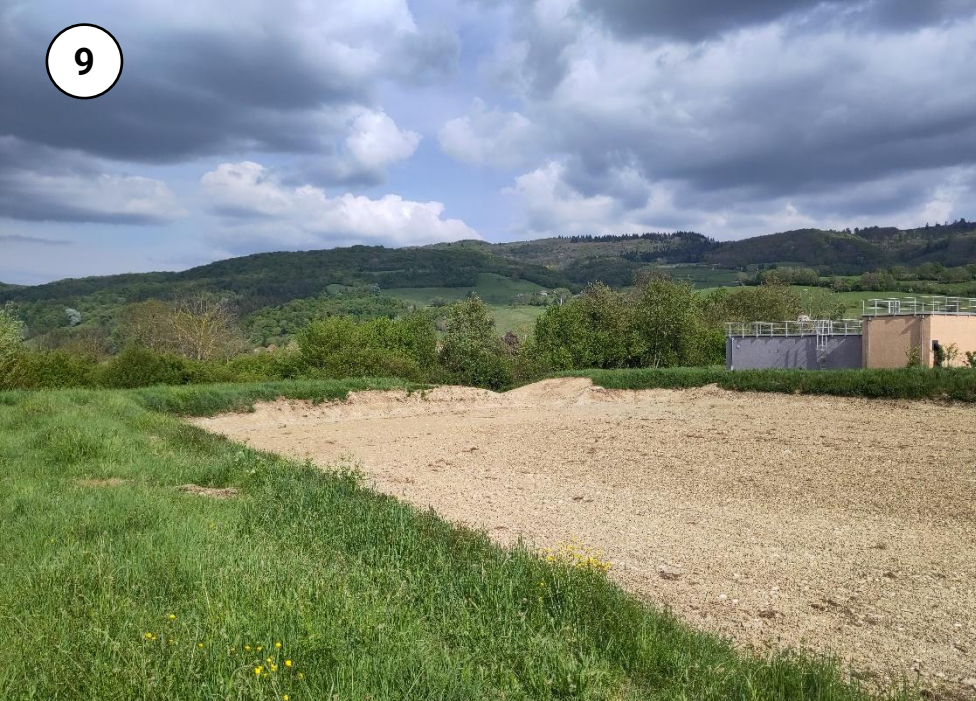
Digue enherbée de circulation pompier
