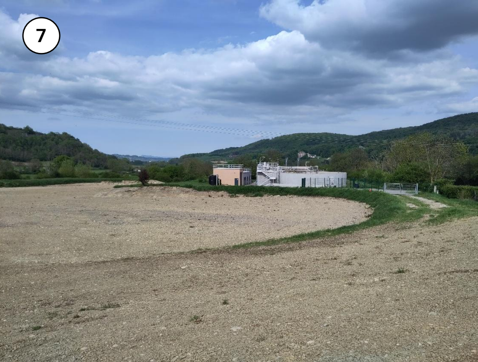
Vue sur l'ancien lagunage et la nouvelle station d'épuration
