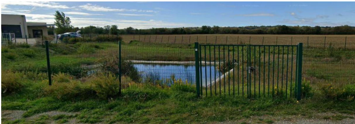
Illustration 32 : Poteau incendie et réserve incendie de 100 m 2 existante (Google Maps, octobre 2025)
