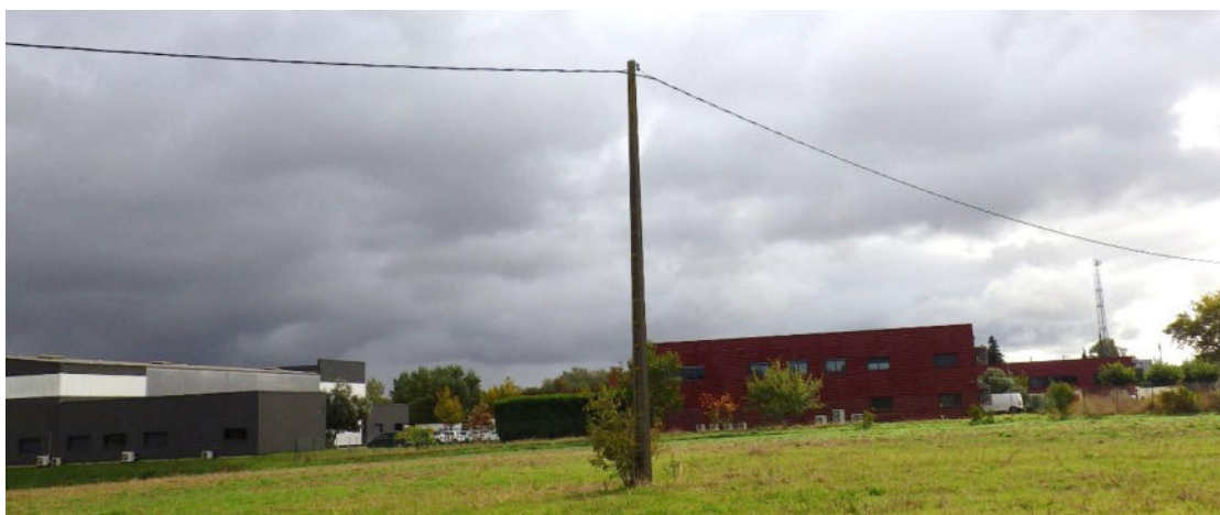
Ligne aérienne basse tension interceptant le site d'étude (ECTARE, octobre 2024)
