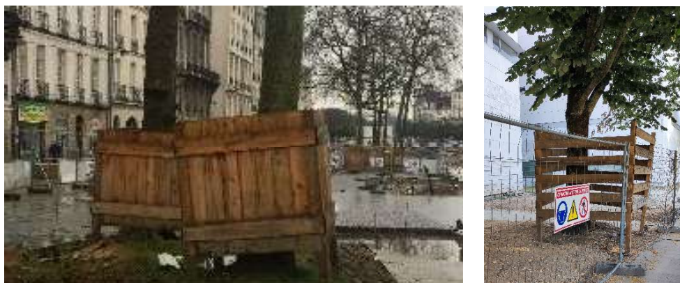
Figure 12 : Exemples de mise en défens des arbres à mettre en place avant les travaux © Biotope
