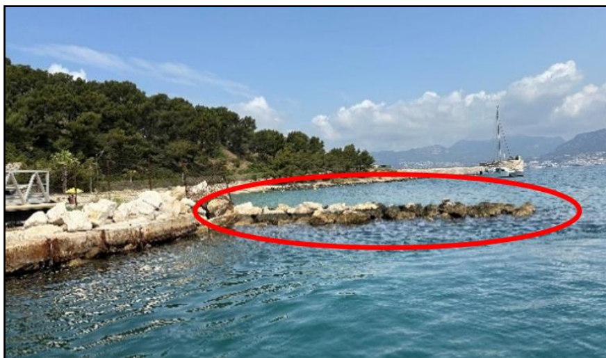
Figure 8 : Tenon en enrochements (ARTELIA, juin 2025)
