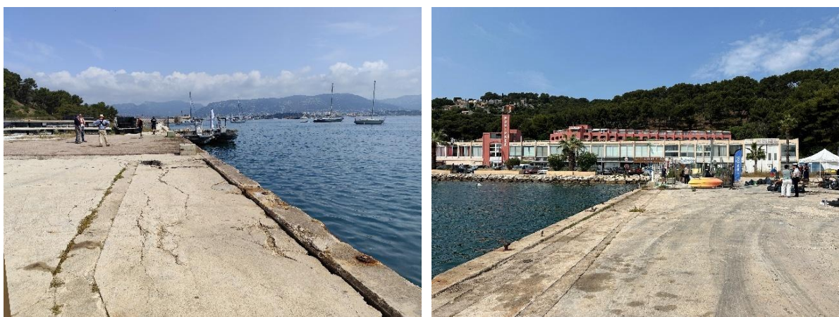
Figure 6 : Magistrale (gauche) et retour du quai (droite) (ARTELIA)
