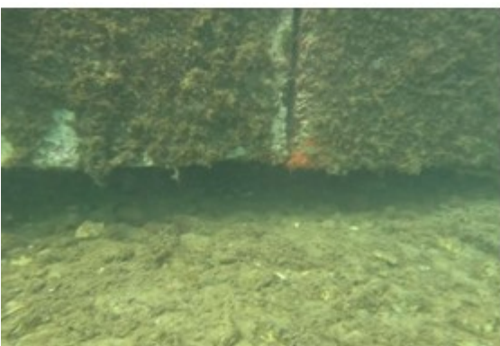
ement du quai bloc
