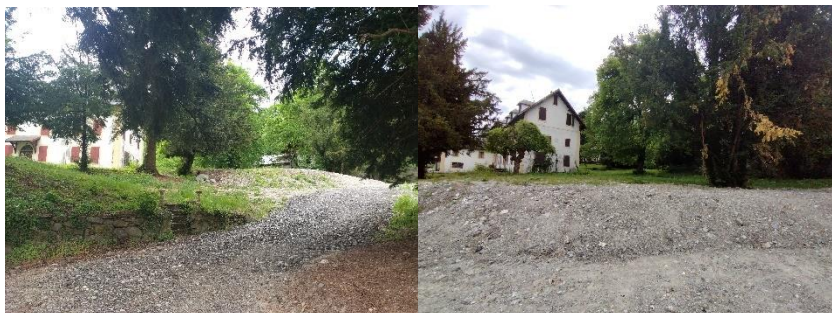
Accès au site et secteur déjà terrassé le long de la résidence Méri-Bellecombe
