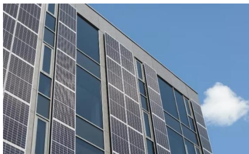
Illustrations de panneaux solaires en façades participant à la composition de la façade à privilégier
