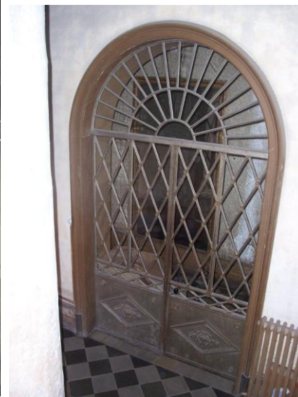
Maison principale – Porte à conserver
