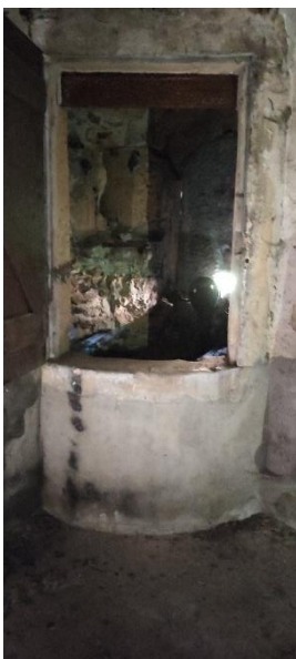
Maison principale – puits à l'intérieur à conserver et valoriser
