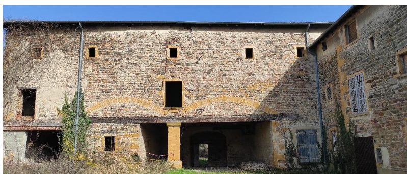
Ancienne dépendance secteur D - Façade sur cour
