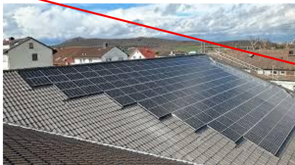
Pose en redans interdite
