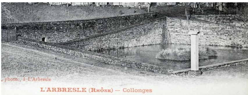
Le bassin à l'origine
