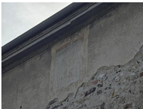
Ancienne dépendance secteur D - Façade donnant sur l'allée avec porche à conserver et fausses fenêtres en décor donnant le rythme et la taille des ouvertures en cas de percement
