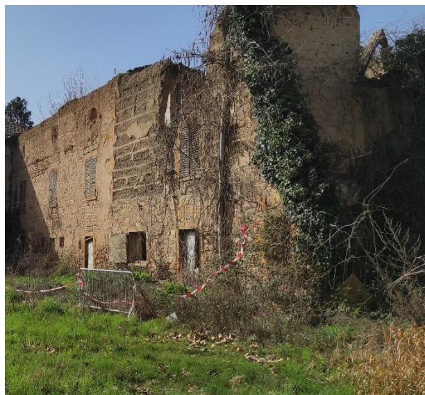
Bâtiment ruiné secteur B
