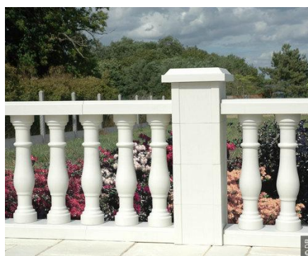
Type de balustres interdit
