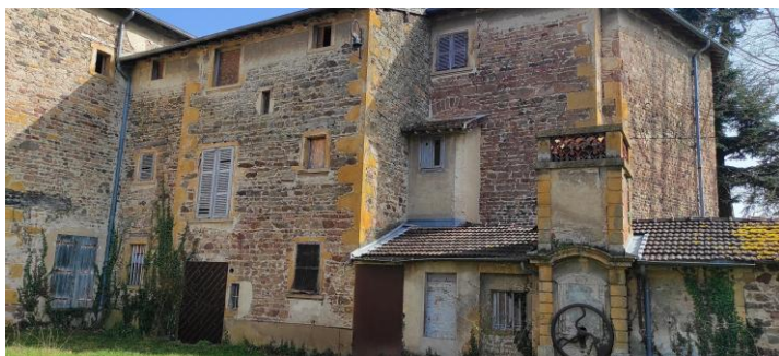
Maison principale – façade sur cour avec son puits
