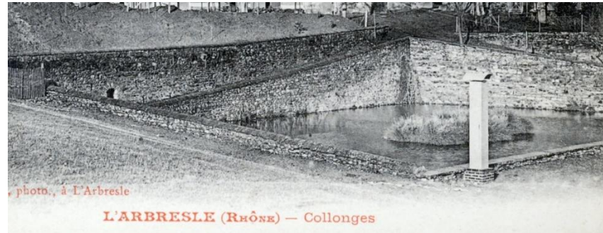
Le bassin à l'origine
