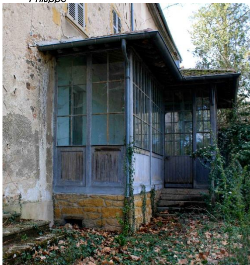
Maison principale – Ancienne verrière à restituer dans son aspect d'origine
