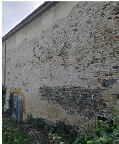
Ancienne dépendance secteur D - Façade donnant sur l'allée avec porche à conserver et fausses fenêtres en décor donnant le rythme et la taille des ouvertures en cas de percement
