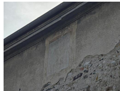
Ancienne dépendance secteur D - Façade donnant sur l'allée avec porche à conserver et fausses fenêtres en décor donnant le rythme et la taille des ouvertures en cas de percement
