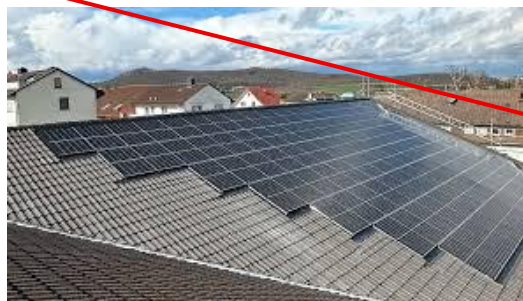
Pose en redans interdite
