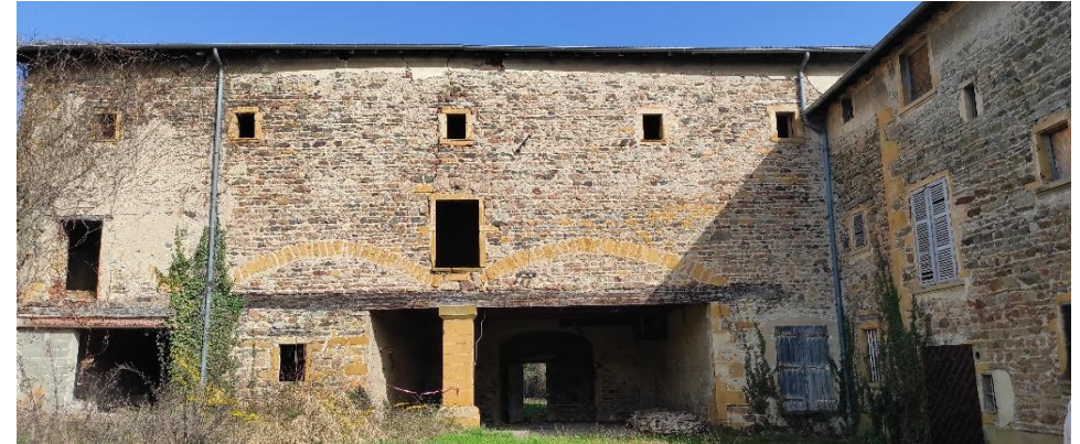
Ancienne dépendance secteur D - Façade sur cour
