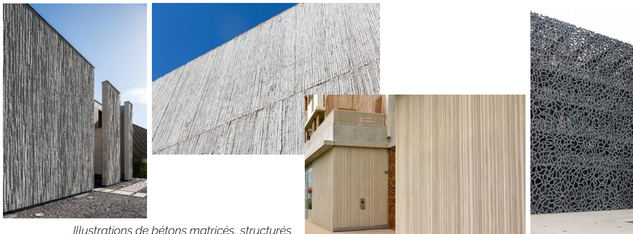
Illustrations de bétons matricés, structurés
