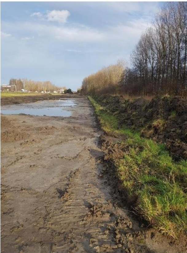
Photo 5 : Site ex-situ 1 reprise du chantier
