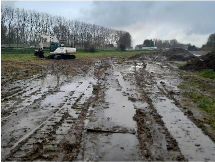
Photo 3 : Site ex-situ 1 - étrépage et export des terres
