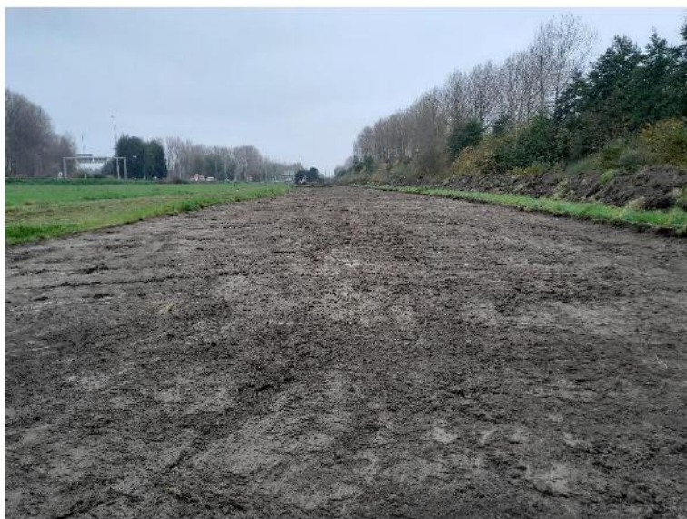
Photo 2 : Site ex-situ 1 - extraction et mise en andain des 10 premiers cm de sol
