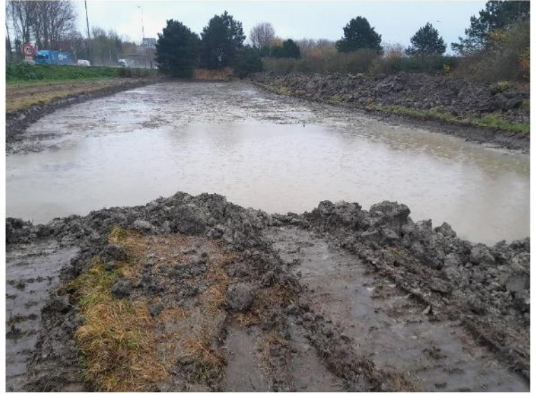
Photo 4 : Site ex-situ 1 - arrêt du chantier
