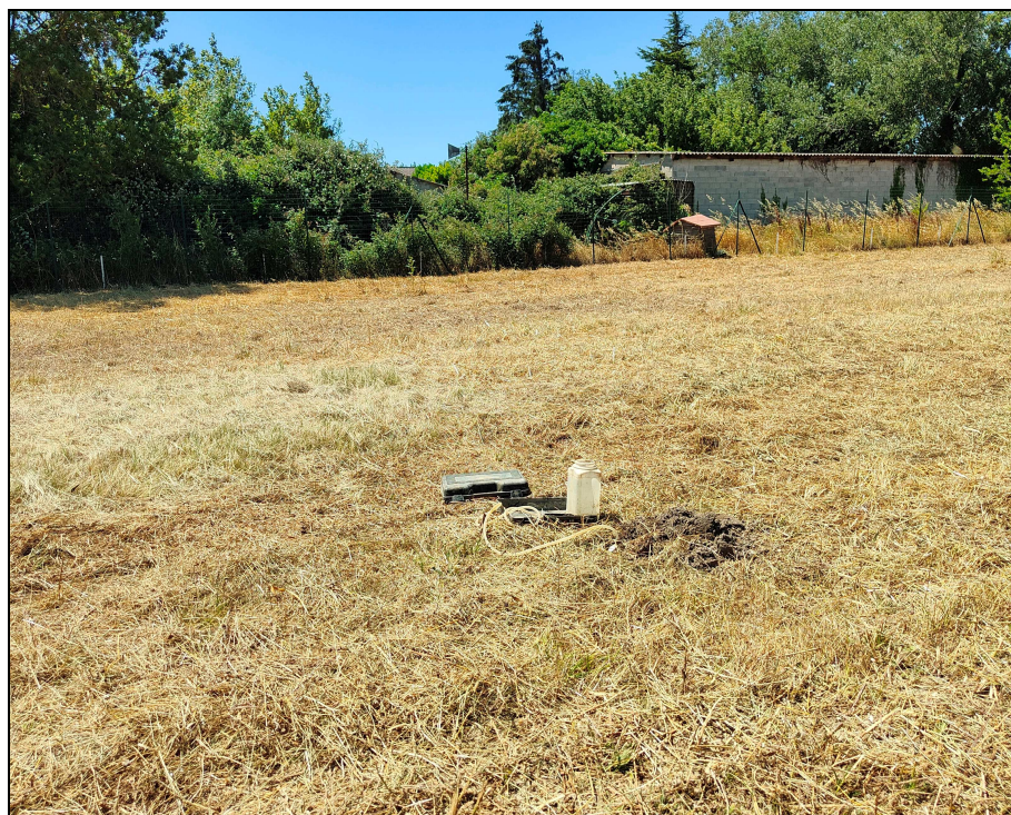
Test d'infiltration – S5
