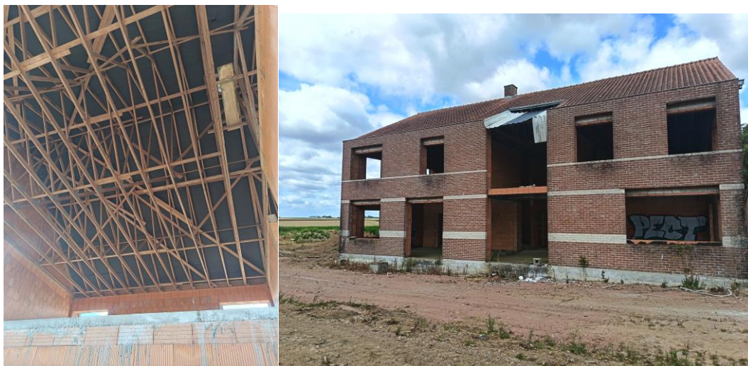
Une structure déjà bien avancée, Source : Visite de terrain VERDI
