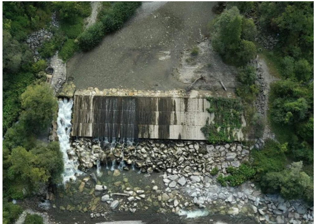
Figure 5 : Prise de vue drone du seuil "naturel" en octobre 2020, montrant déjà l'impact de la dalle marno-calcaire sur la dérivation des eaux en rive droite.
