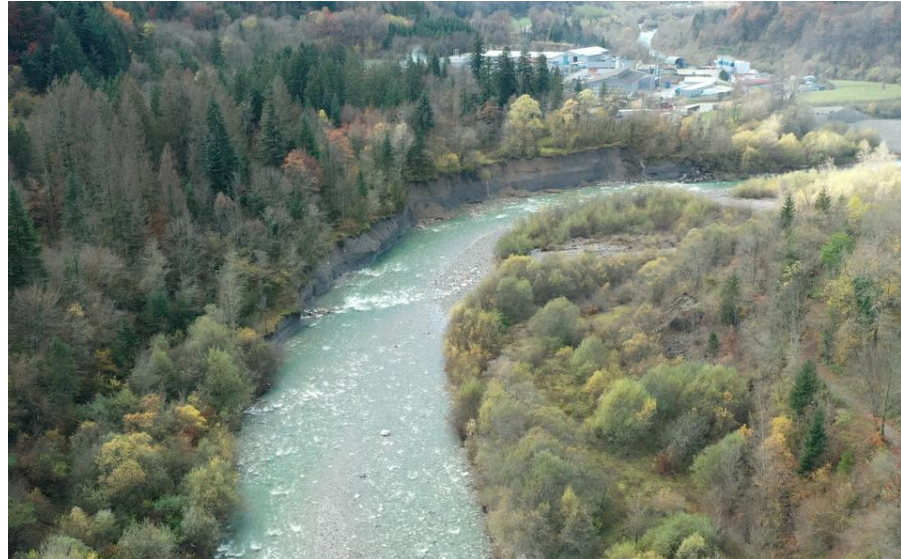
Figure 6 : Prise de vue drone de la berge en rive gauche en aval des contre-seuils
