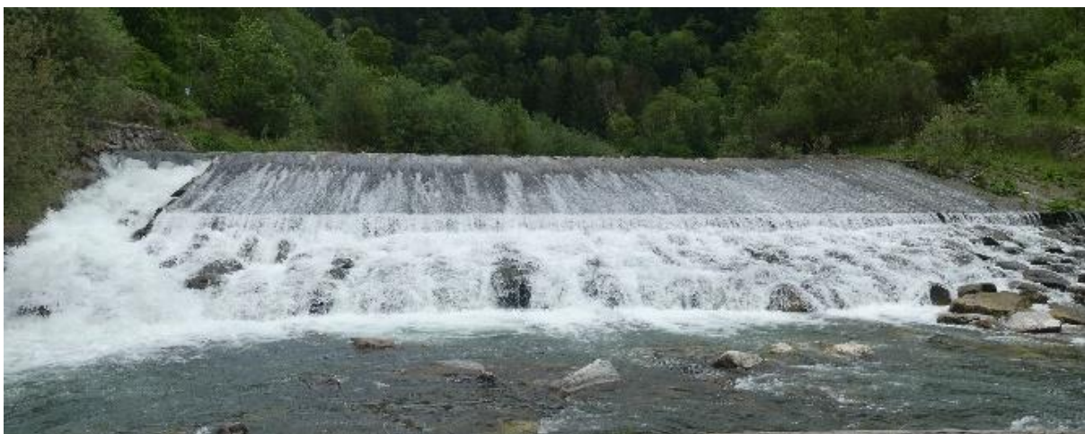
Figure 4 : Seuil naturel : code ROE 24543 ; hauteur h \sim 5 m (HYDRETIJDES 05/2023)
