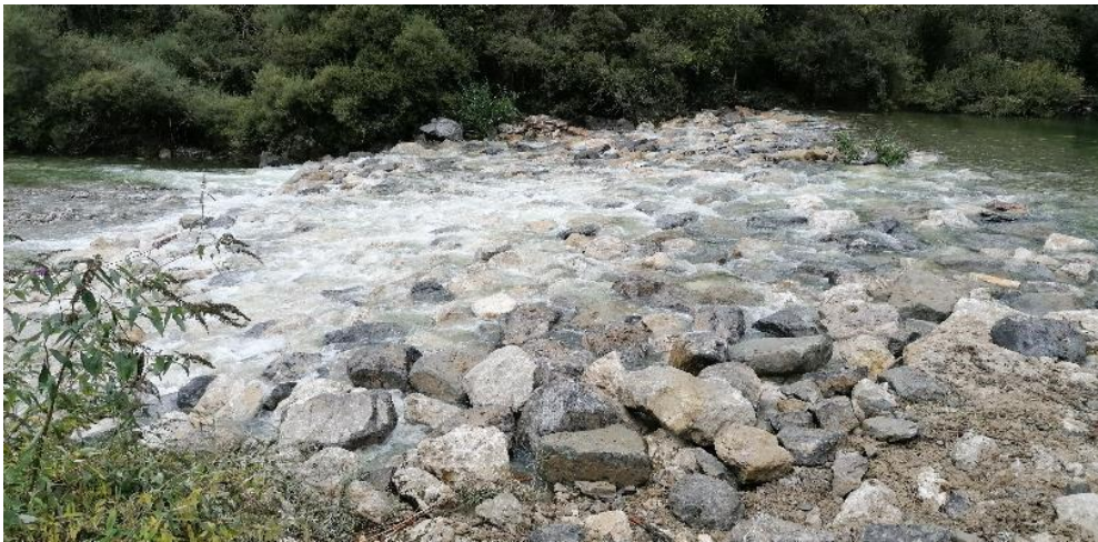
Figure 3 : Contre seuil : code ROE 24538 ; hauteur h \sim 3,5 m (photo à-fin octobre 2020 après confortement provisoire)
