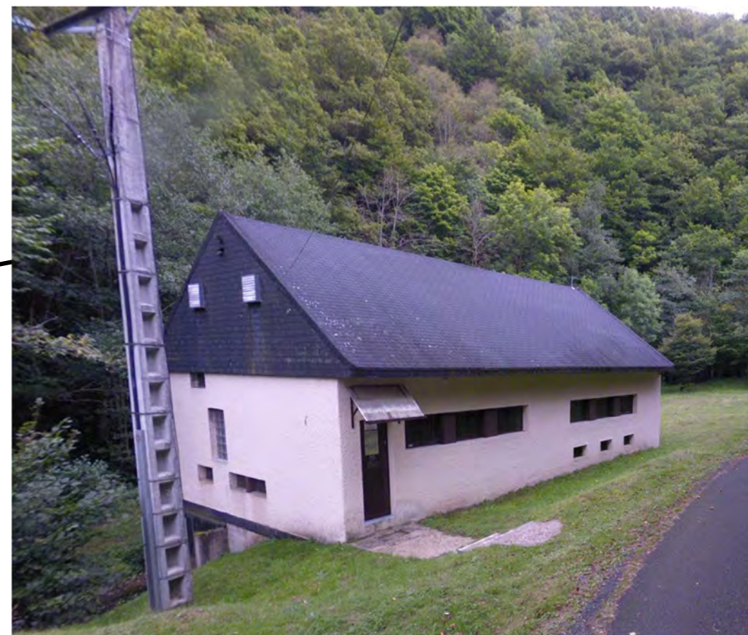
Bâtiment de production
