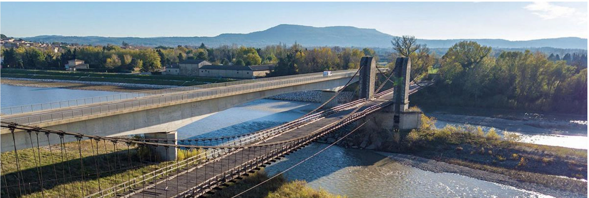
Source Mairie de Mallemort – Vue par drone vers l'ancien pont suspendu MH3.
