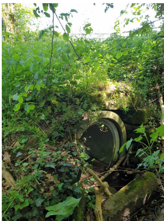
Vue sur le busage en amont du chemin
