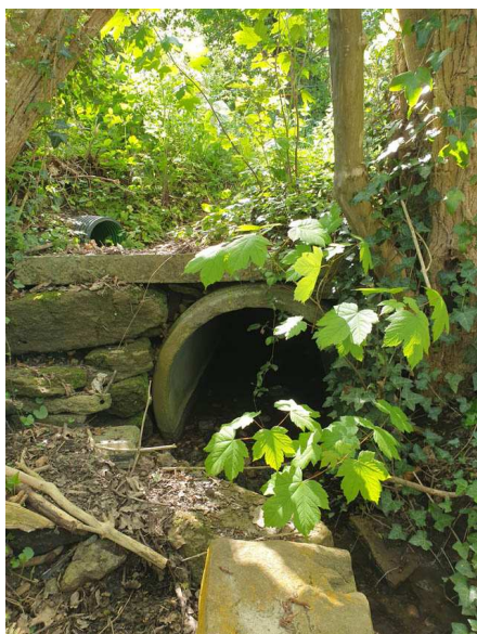
Vue sur le busage en aval du chemin
