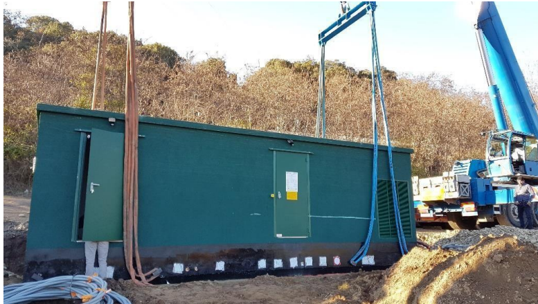
Figure 4 : Photographie de l'installation d'un local technique
