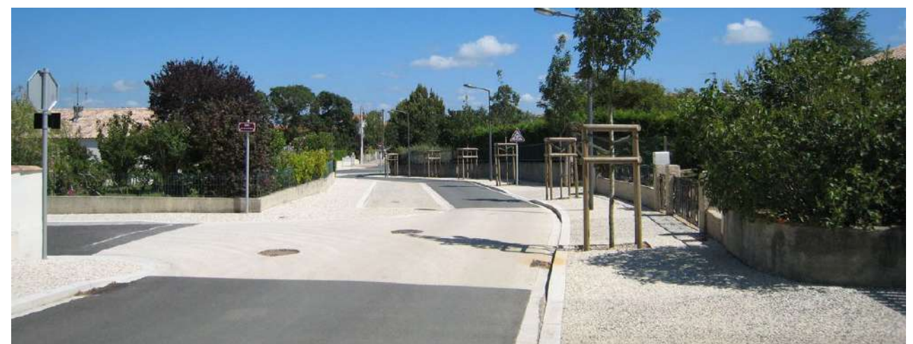
Carrefour marqué en résine pépite ou Roxem
