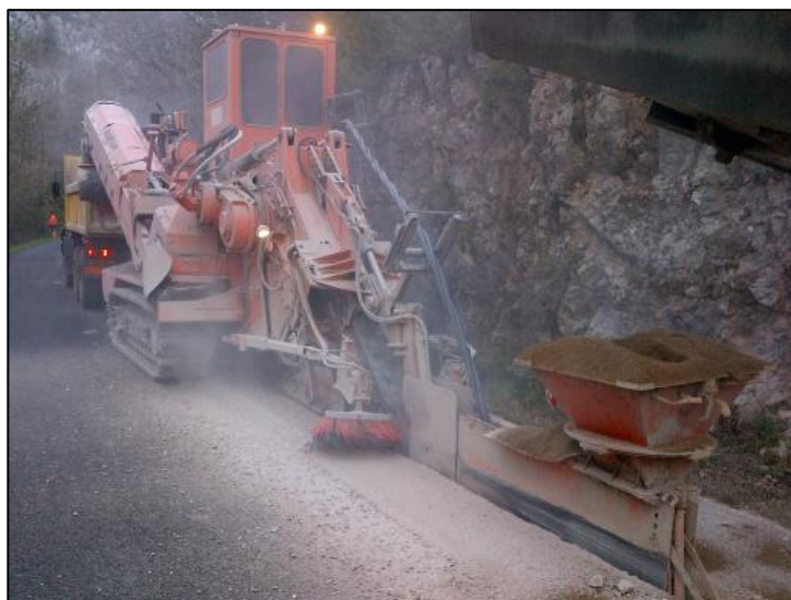
Figure 28 : Photo de trancheuse prise sur chantier (Source : wpd)
