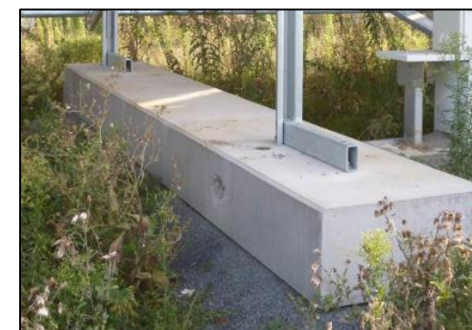
Figure 18 : Type de fondation – semelle béton
