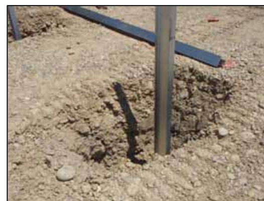
Figure 17 : Types de fondation - pieux battus
