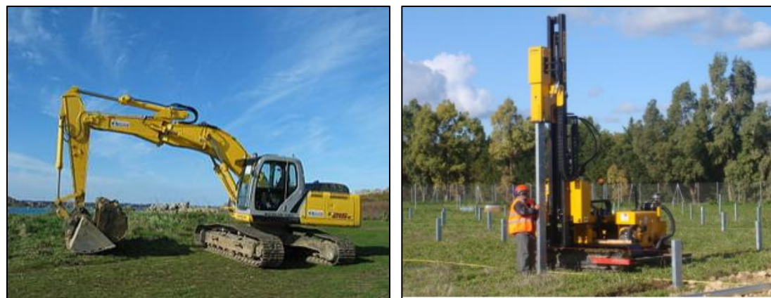
Figure 31 : Exemple d'une pelleteuse et d'une batteuse de pieux (Source : Mécanique Hydraulique s.d. et Parjot s.d., wpd)
