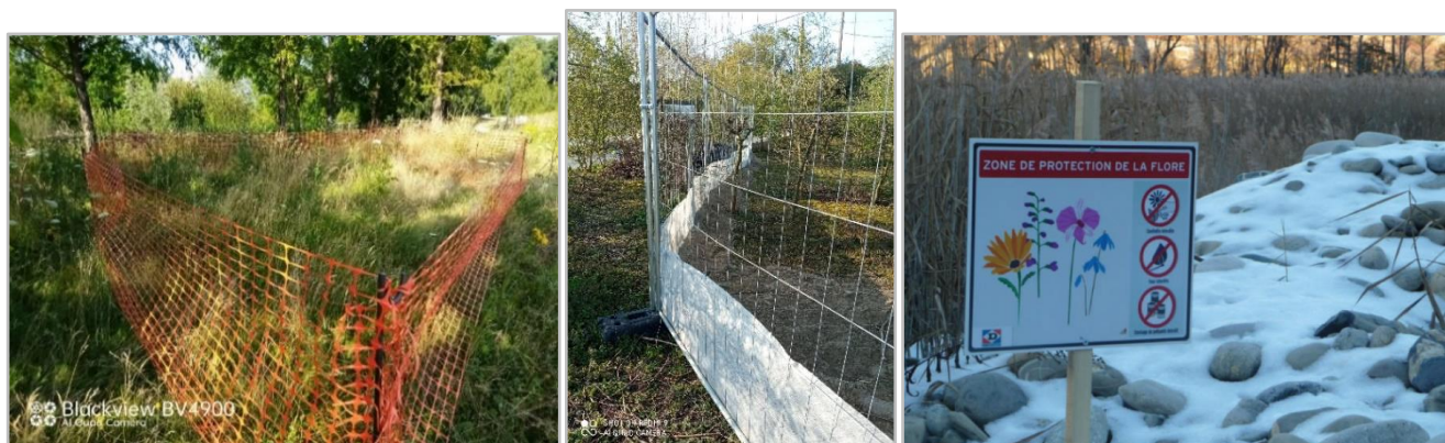
Photos 20 : Exemple de moyens de balisage : Grillage de signalisation (à gauche) ; Barrières HERAS (au centre), © Rainette ; Exemple de panneau d'information (à droite), © Google
