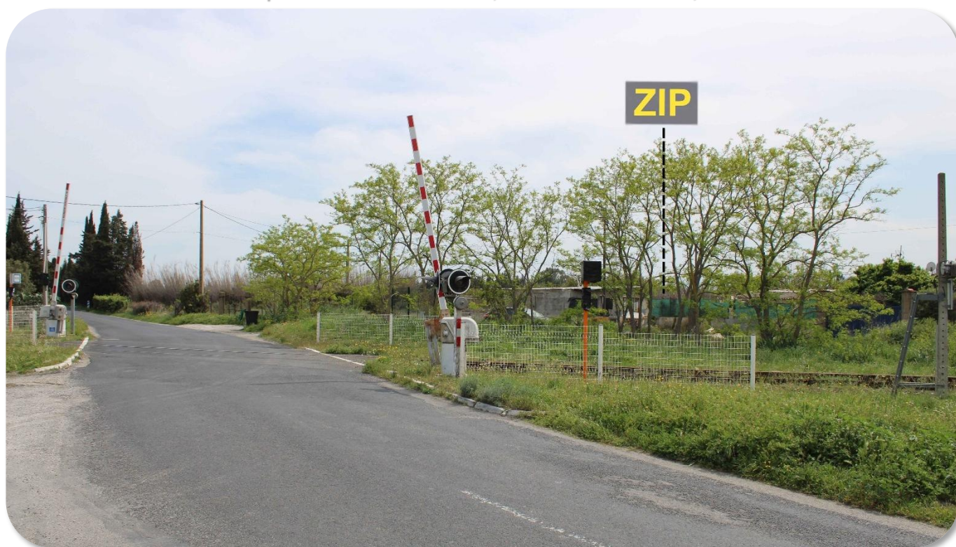
Photo 17 : Vue n°12 depuis l'habitation els Censals, la RD5d et la voie ferrée, en direction de la ZIP
