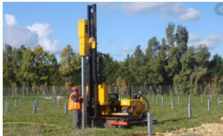
Figure 26 : Ancrage des pieux battus
