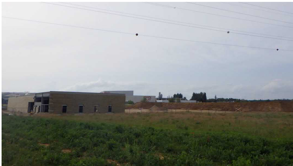
Zone de construction d'un bâtiment au sud-ouest du site n°5 – Juin 2022
