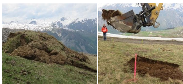
Test d'étrépage, godet plat et stockage des mottes (Mai 2018)
