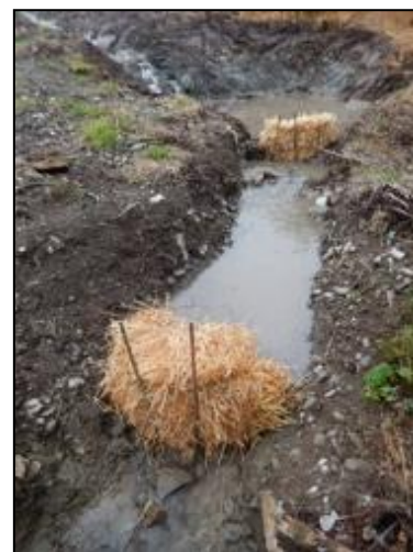
Exemple d'un système de filtration d'un cours d'eau. Crédit : KARUM
