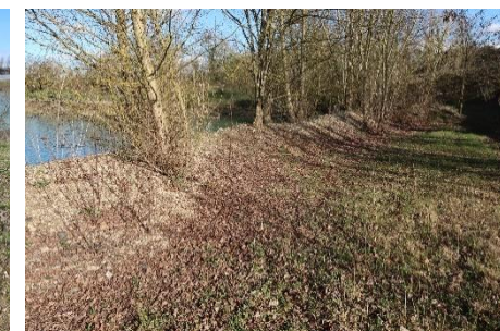
Merlon entre le plan d'eau et le lieu-dit « Lasbouères » Source : ARTIFEX 03/2023
