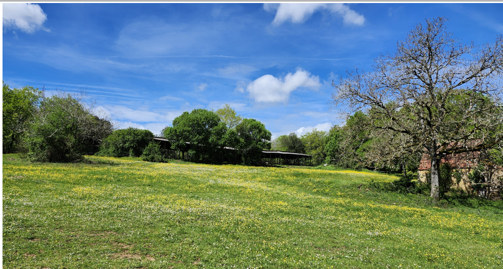
1.1 Vue actuelle en direction du hangar à rénover depuis le bas du site
