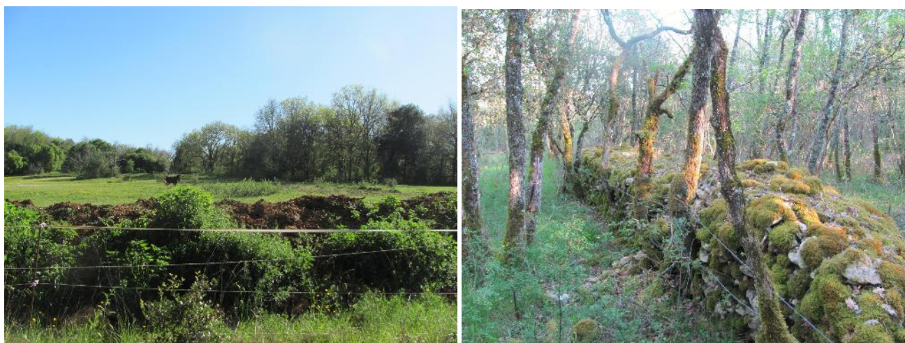
Figure 8 : Merlon de terre en limite est et muret en pierre en limite ouest du site
