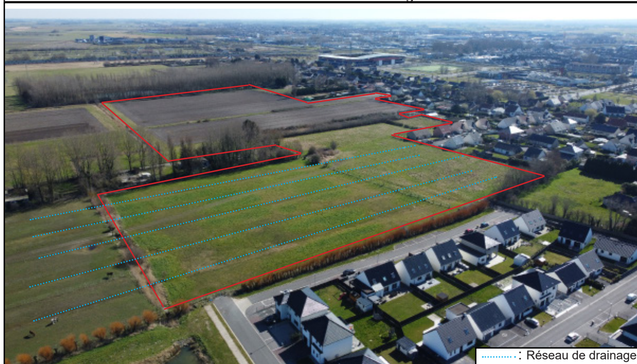
Photo 1 : Identification du réseau de drainage au sein du site
