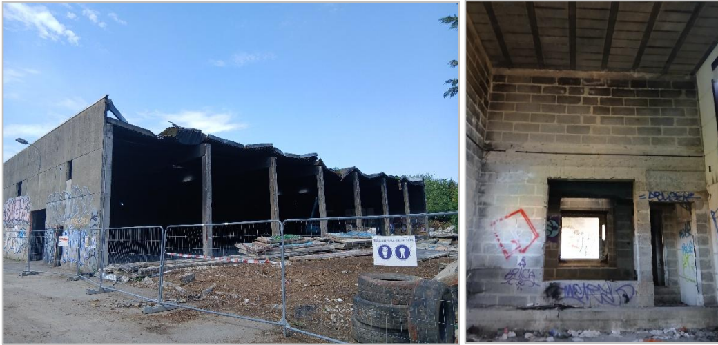
Photo 17 : À gauche : bâtiments centre-est en cours de désamiantage, à droite : bâtiment sud ouvert et en cours de démolition sur la partie de la friche Mossley.
