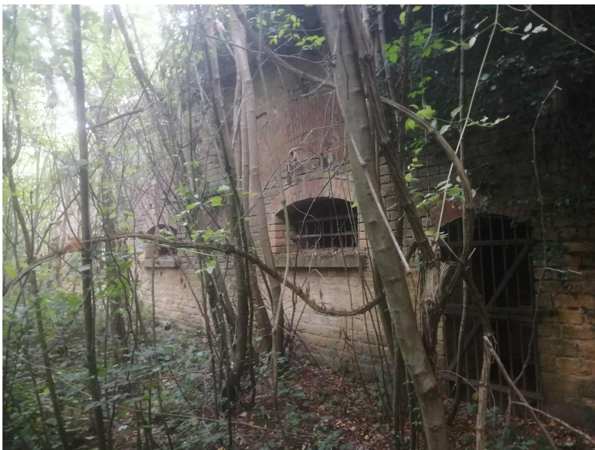
Figure 5 : Ouvrage militaire hors projet (au Sud-Ouest)
