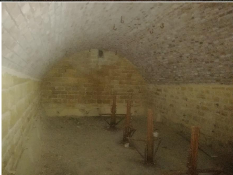
Figure 10. L'abri souterrain est parfois visité. La maçonnerie d'excellente facture n'offre aucun disjointement aux chauves-souris.
