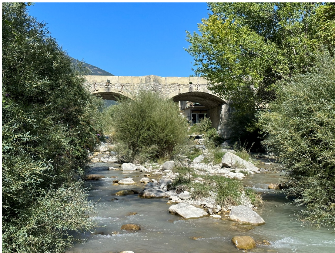
Figure 2 : Vue du pont en partie aval de la zone projet
