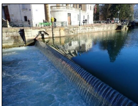
Figure 29 : Vannes contrôlant le niveau de l'eau
