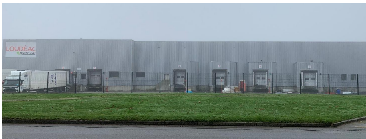
Figure 9 : Vue du site depuis la rue Arthur Enaud
