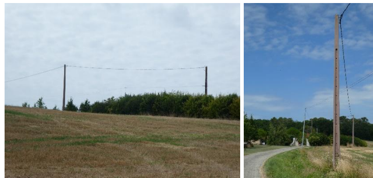
Photographie 11 : Lignes électriques au sud du site (Source : ENCIS Environnement)
