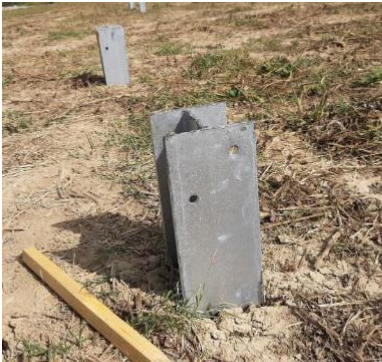
Photographie 2- Exemple de pieux battus (source : REDEN)
