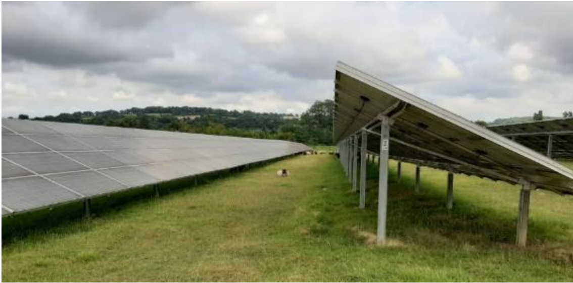
Photographie 1 - Exemple de structure fixes (source : REDEN)
