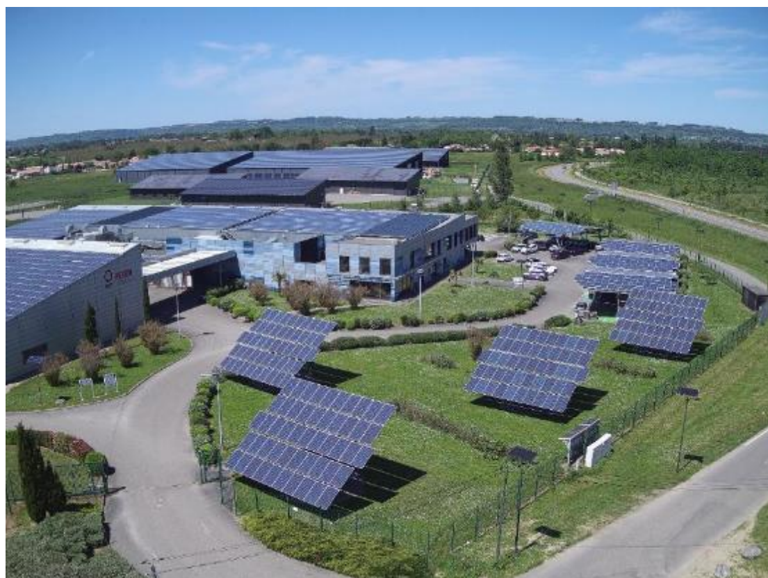
Figure 6 - Siège du groupe REDEN – ROQUEFORT (47)
