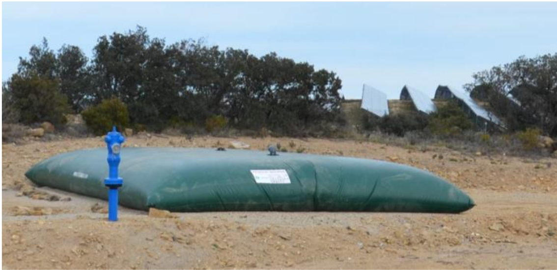
Figure 29 - Bâche à eau (source : REDEN)
