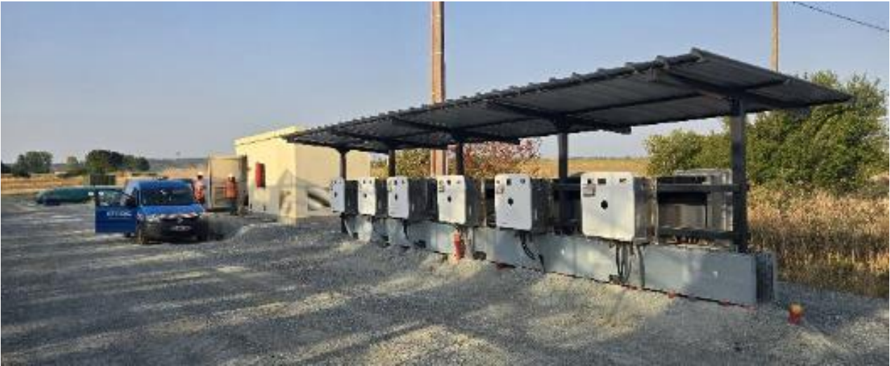
Figure 19 - Exemple de support onduleurs (source : REDEN)
