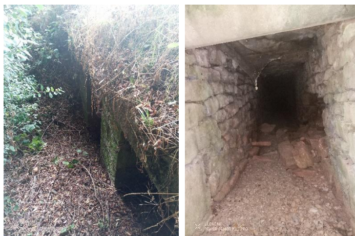
Ouvrage hydraulique potentiellement favorable aux chiroptères
