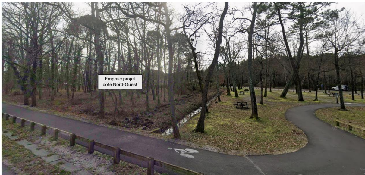
Figure 37 : Photographie du fossé et des pistes cyclables périphériques à l'emprise projet (Source : Google Maps – février 2024)
