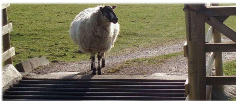
Exemple de réalisation de passage canadien pour le bétail :
