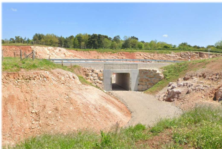
Exemple de réalisation de passage inférieur pour le matériel :
