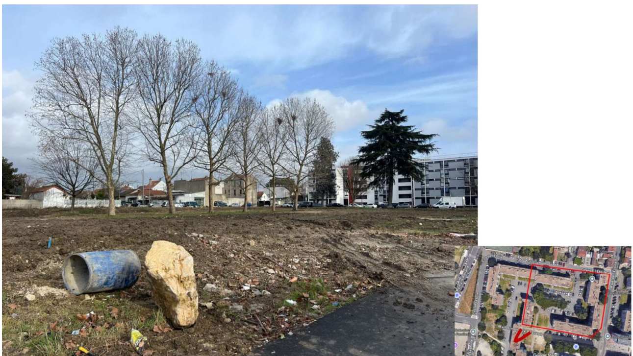
Figure 7 : Prise de vue depuis le Sud-Ouest du site – janvier 2026 (Groupe Pierreval)
