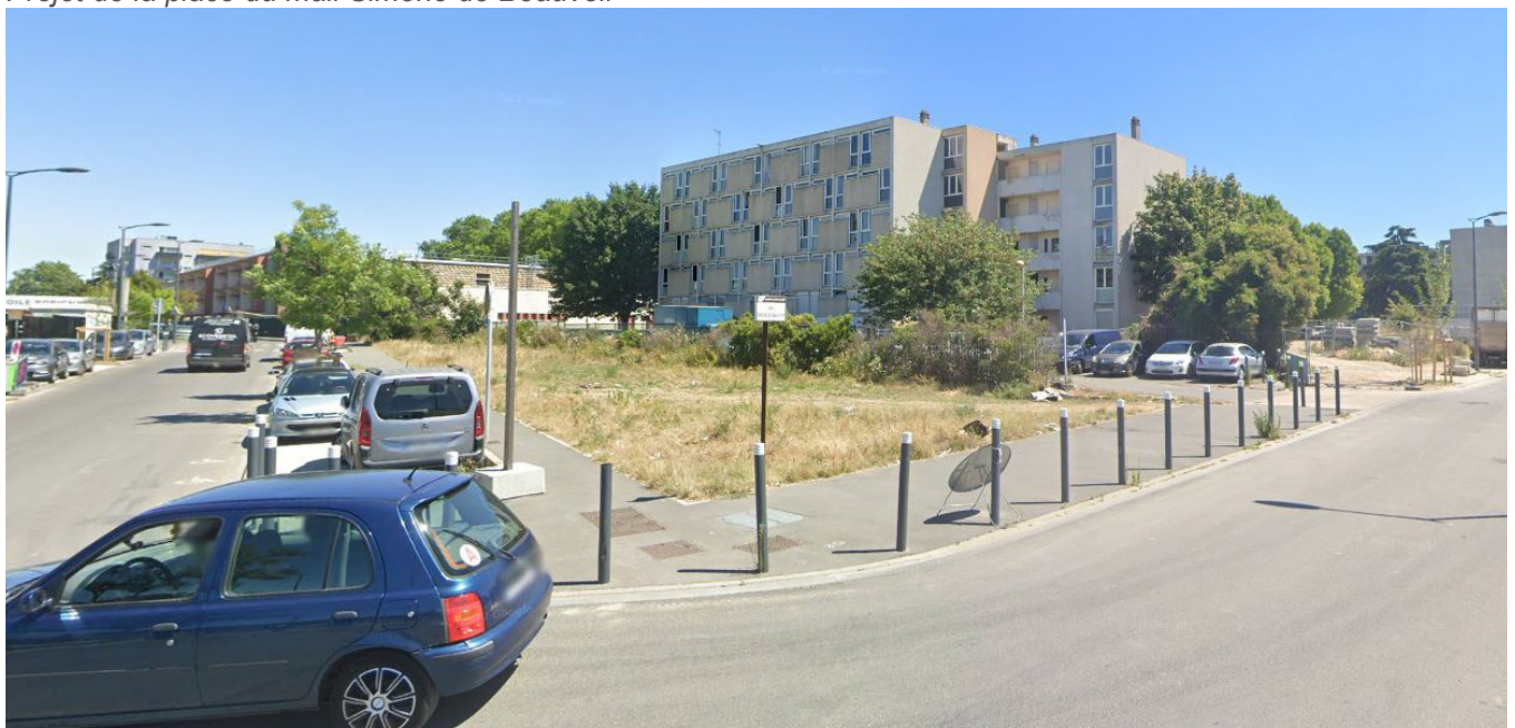
Angle du mail Simone de Beauvoir et de la rue Romain Rolland (avant la démolition du bâtiment F en 2023)
