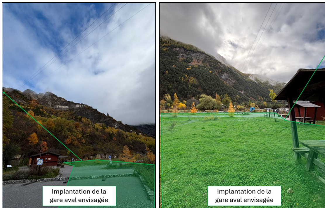
Figure 5 : Vue de la gare aval Tracé vert
