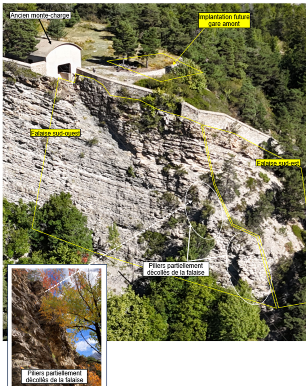
Figure 8 : Photographie des falaises bordant la gare amont
