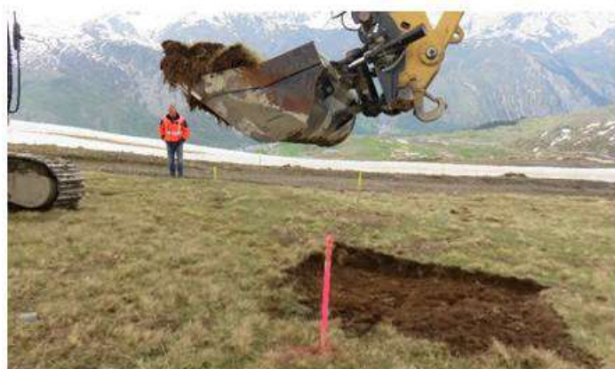
Test d'étrépage, godet plat et stockage des mottes (Mai 2018)
