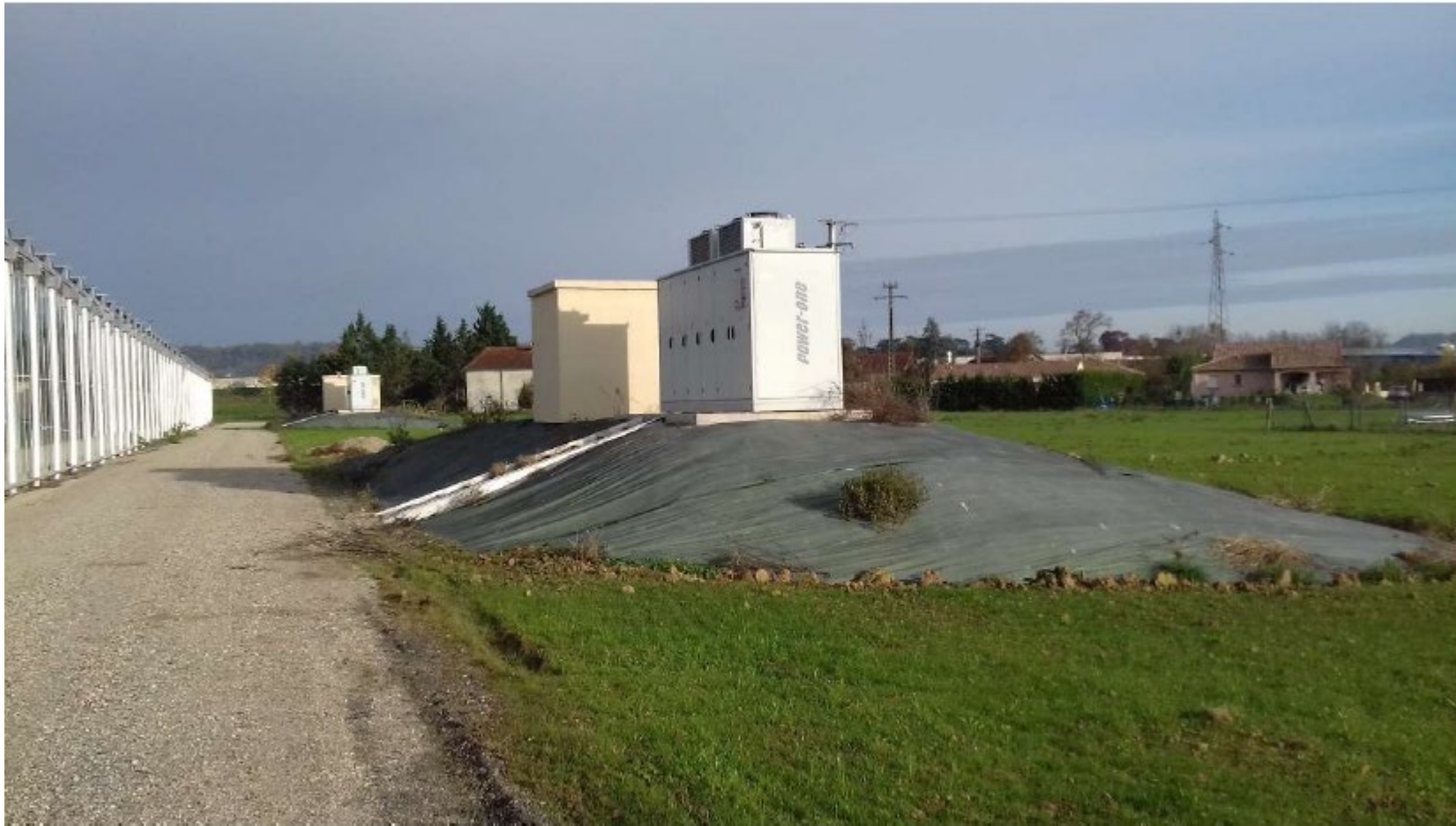
Figure: Poste de transformation réhaussé (Source: REDEN)
