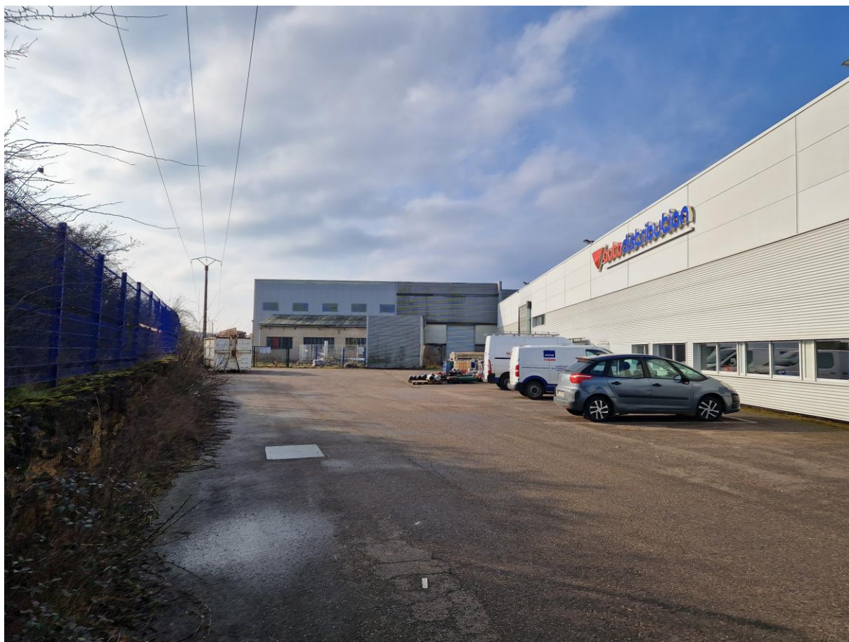
15 : Vue du Nord vers le Sud sur la partie arrière de la halle Nord à droite et de la halle Sud au fond avec la station de pompage-traitement des eaux (barrière hydraulique). A gauche le talus de la voie ferrée qui longe le site du projet à l'Est
