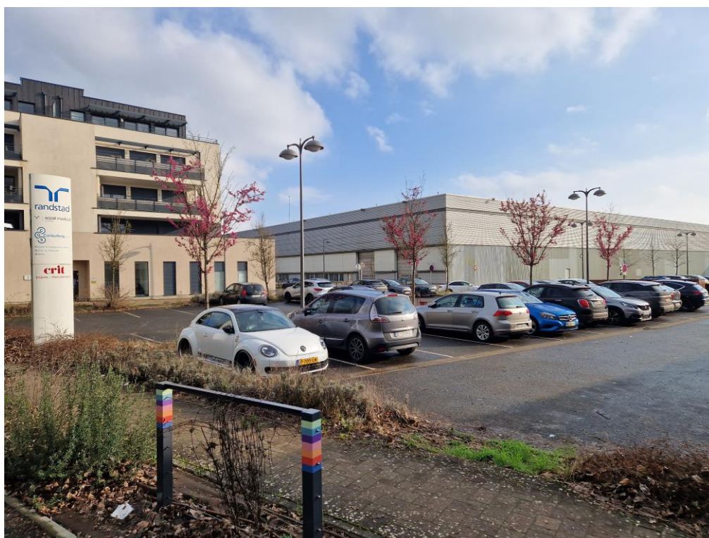
2 : Vue sur l'angle Sud-ouest de la halle Sud depuis la voie piétonne le long de la RD 653, à gauche les bâtiments construits sur la frange Ouest de la ZAC de l'Emaillerie (entre la RD 653 et le projet)
