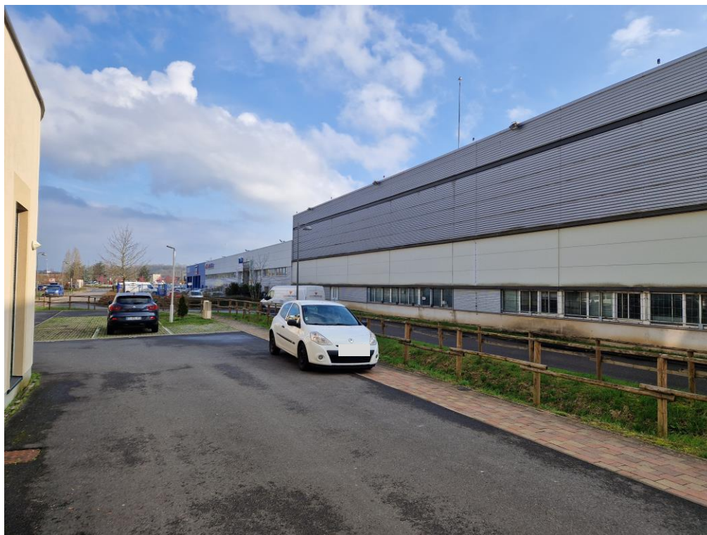
8 : Vue sur la salle Sud, et la halle Nord en continuité, depuis les constructions à l'Ouest dans la ZAC de l'Emaillerie
