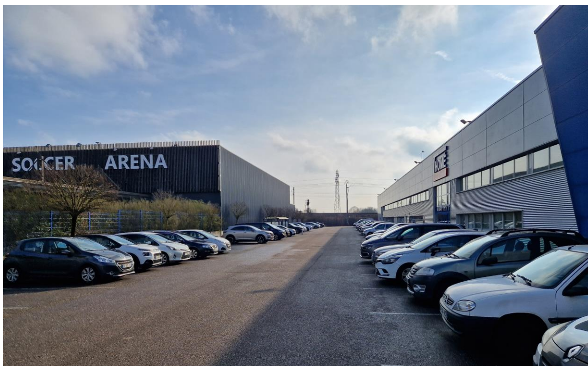
14 : Vue sur la halle Nord à gauche et le complexe sportif Soccer Arena en limite Nord du projet, en arrière-plan vue sur le talus de la voie ferrée qui longe le site du projet à l'Est
