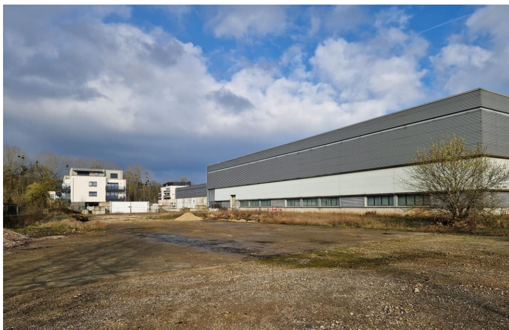
6 : Vue depuis l'angle Sud-est du site sur l'ancienne déchetterie site industrielle au Sud de la halle Sud
