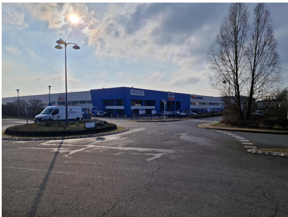
12 : Vue sur la halle Nord, occupée par des activités, et le giratoire desservant la ZAC de l'Emaillerie au Nord, se raccordant sur le giratoire principal sur la RD 653 (non visible sur la photo mais situé à droite)
