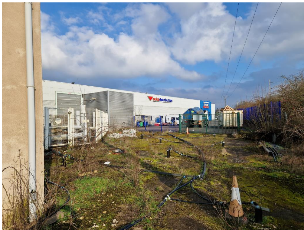
7 : Station de pompage/traitement des eaux souterraines (barrière hydraulique) toujours active en périphérie de la halle Sud
