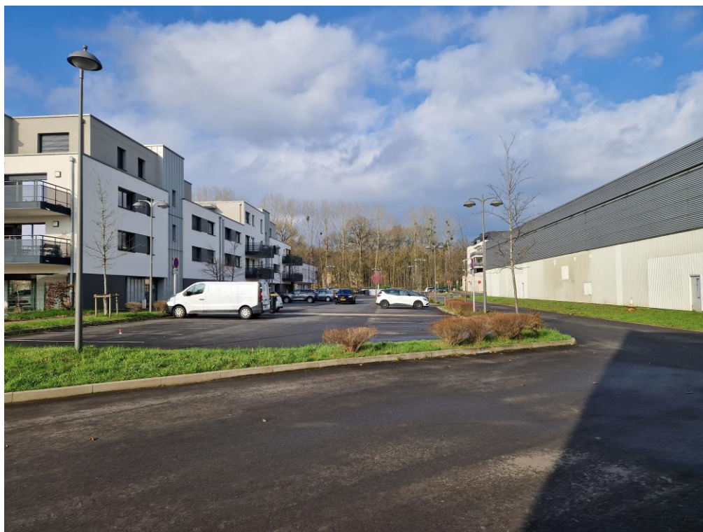
3 : Vue sur la zone de stationnement située entre les bâtiments construits dans la ZAC de l'Emaillerie à gauche et la halle Sud à droite
