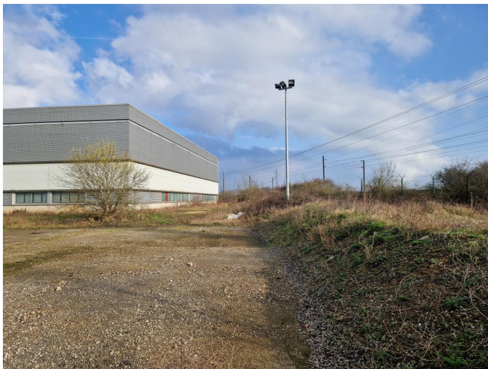
5 : Vue sur la partie Sud-est de la halle Sud (vue vers le Nord), à droite la voie ferrée
