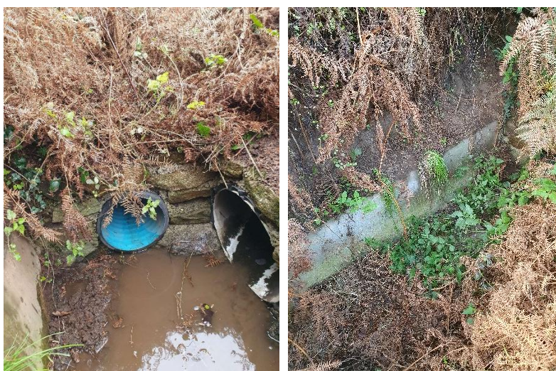
Figure 6 : Canalisations se rejetant sur le terrain du projet
