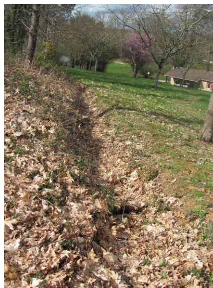
Figure 22 : Grille de caniveau sans traces d'écoulement et fossé toujours remplis de feuilles en mars 2026, sans traces des ruissellements
