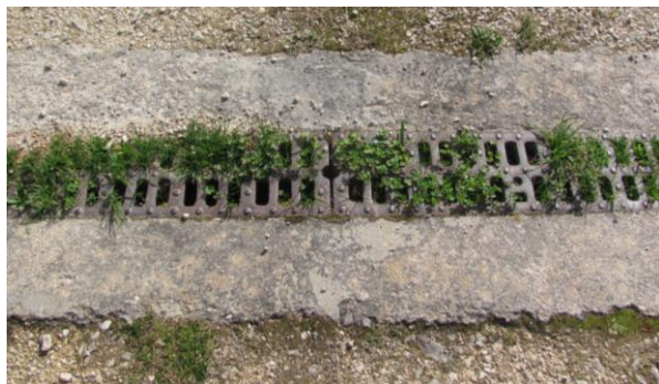
Figure 22 : Grille de caniveau sans traces d'écoulement et fossé toujours remplis de feuilles en mars 2026, sans traces des ruissellements
