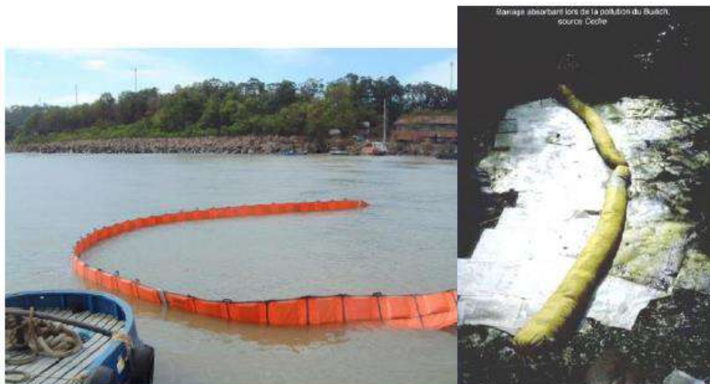
Figure 68. Installation d'un barrage flottant ( http://www.flexitankchina.fr ) / barrage absorbant (cedre.fr)
