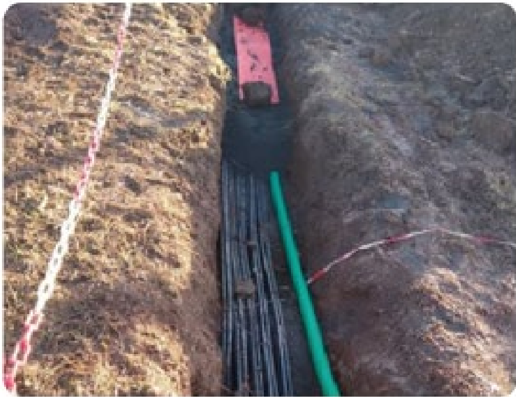
Figure 11 : Tranchée pour câble souterrain. Source : Enoé
