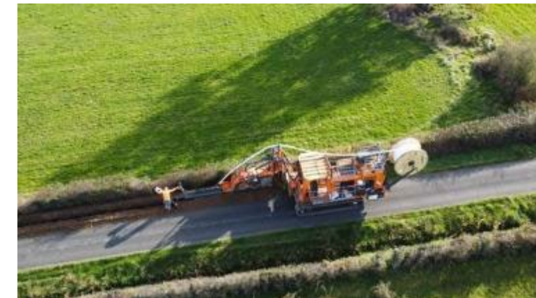
Figure 16 : Pose de lignes souterraines
