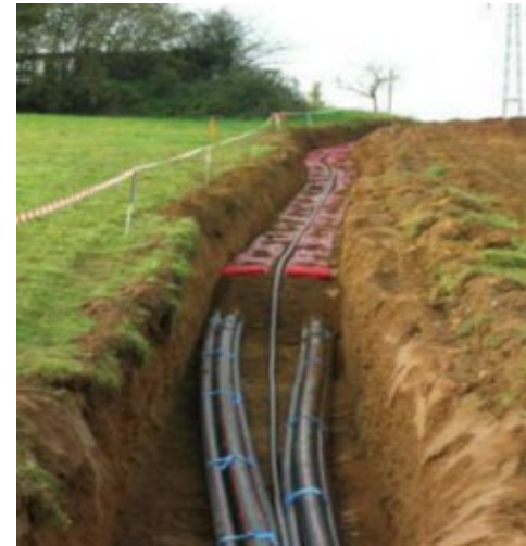
Figure 15 : Illustrations de l'installation des liaisons souterraines selon la pose en PEHD
