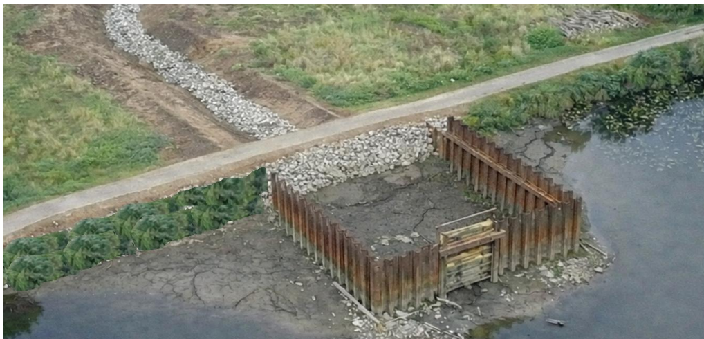
PHOTOMONTAGE ILLUSTRANT LE PRINCIPE DU BATARDEAU-SYSTEME DE VIDANGE
