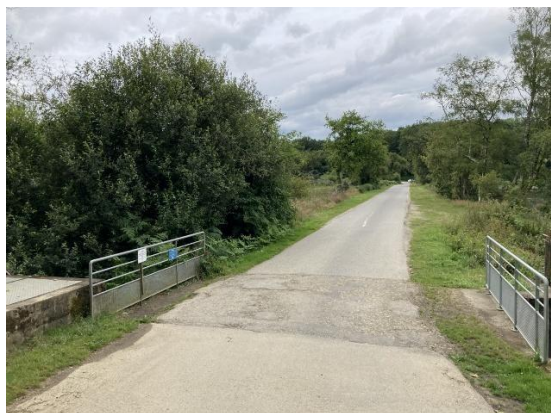
VUE DE LA DIGUE-ROUTE COTE SUD
