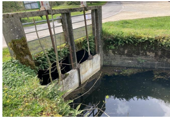
VUE DES VANNES DEPUIS L'AMONT
